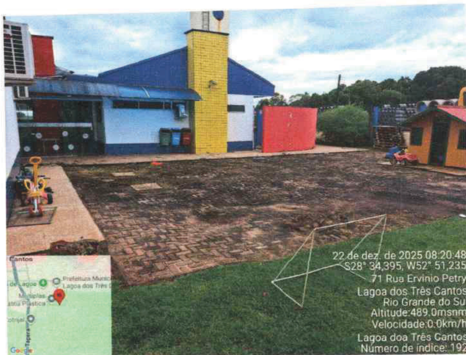
Demolição da granitina e execução de calçada de concreto, em quadros, nova com dilatação Plantio de grama
