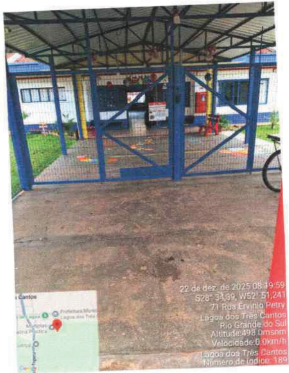
Pintura das calçadas
