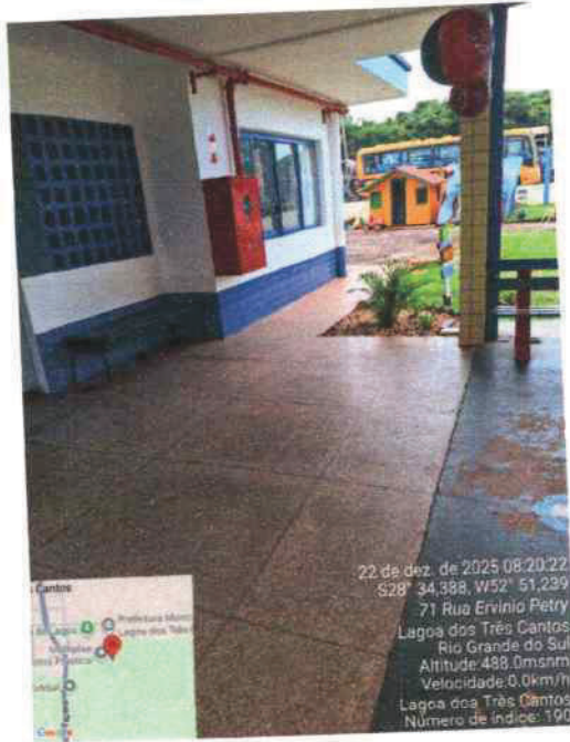
Pintura da granitina da entrada também e execução de calçada nova a esquerda. Bem como adequação das bandeiras com piso no local em frente a calçada nova( conf. Planta)
