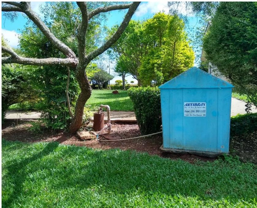
Figura 8. Estrutura ainda existente no local do poço tubular desativado
